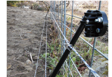
下向きに取付て、掘り起し・よじ登り対策
